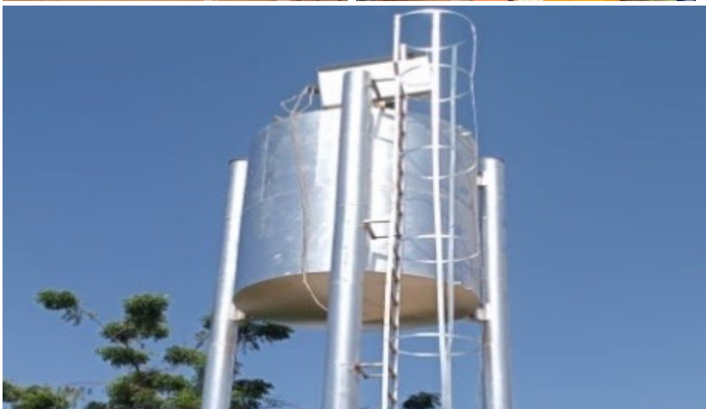
Forages communautaires construits et réhabilités, Seytenga/Falagountou, 2023 et château réalisé à Bogandé, 2023
